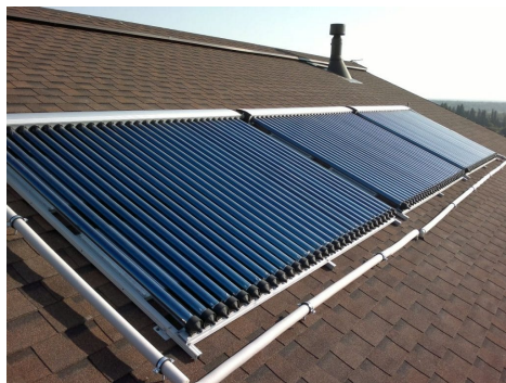
Рис. 2.8 – Вакуумний колектор на даху будинку
