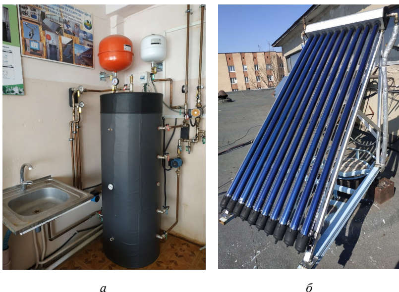
Рис. 2.10 – Загальний вигляд стенду всесезонної сонячної геліосистеми гарячого водопостачання з використанням вакуумного колектора: а – сонячний вакуумний колектор; б – бак-акумулятор
